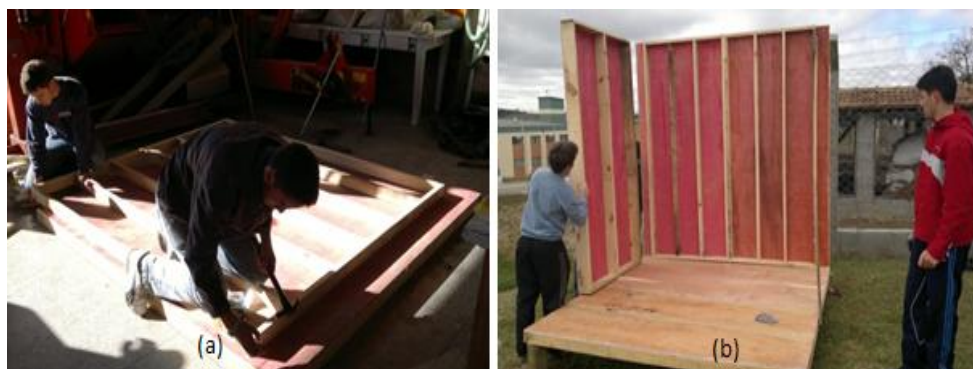
Figura 2. Construção dos protótipos: (a) execução das paredes e plataformas em galpão; e (b) montagem das paredes auto portantes sobre a plataforma no local.
