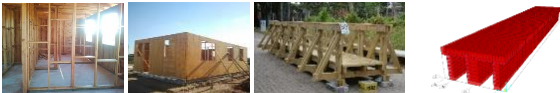
Figura 5. Sistemas constructivos en desarrollo en Uruguay: a) entramado ligero; b) reticulado; c) Puente con vigas de MLE y tablero con paneles CLT
