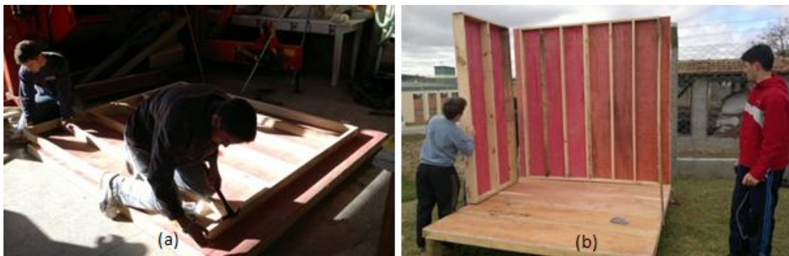
Figura 1. Construção dos protótipos: (a) execução das paredes e plataformas em galpão; e (b) montagem das paredes auto portantes sobre a plataforma no local
