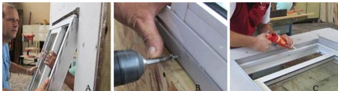
Figura 9. Instalação da Esquadria (A) – Fixação da Esquadria (B) e Aplicação de Silicone (C). Fonte: O próprio autor
