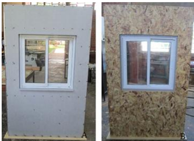
Figura 10. Fixação da Esquadria (A) e Aplicação de Silicone (B). Fonte: O próprio autor
