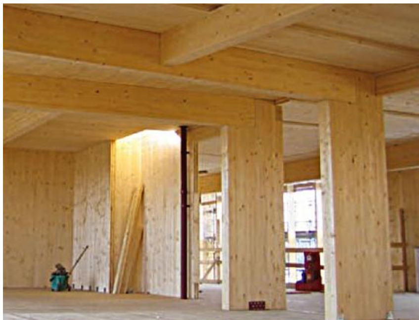
Figura 3: Vista interna durante a construção de uma edificação em CLT. Fonte: LENDLEASE, 2014.
