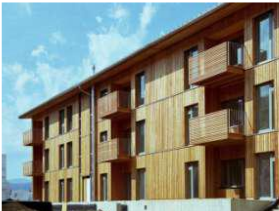
Figura 4: Edificação de moradias populares em CLT. Fonte: SCHICKHOFER, 2011.
