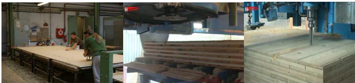
Figura 2: À esquerda, correção de imperfeições de uma das faces visíveis; No centro, painel sendo cortado na serra CNC; E à direita, execução de canaleta para instalações elétricas. Fonte: PASSARELI, 2013.
