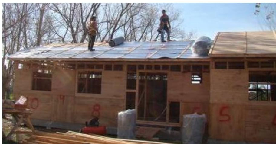
Figura 8. Aplicação no telhado de manta isolante térmica, fixada por taliscas de madeira.
