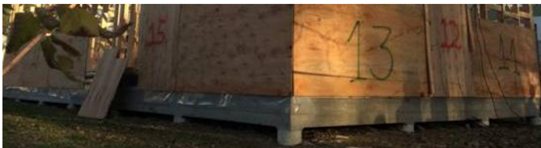
Figura 5. Fundação de concreto em uma das construções visitadas em La Plata.
