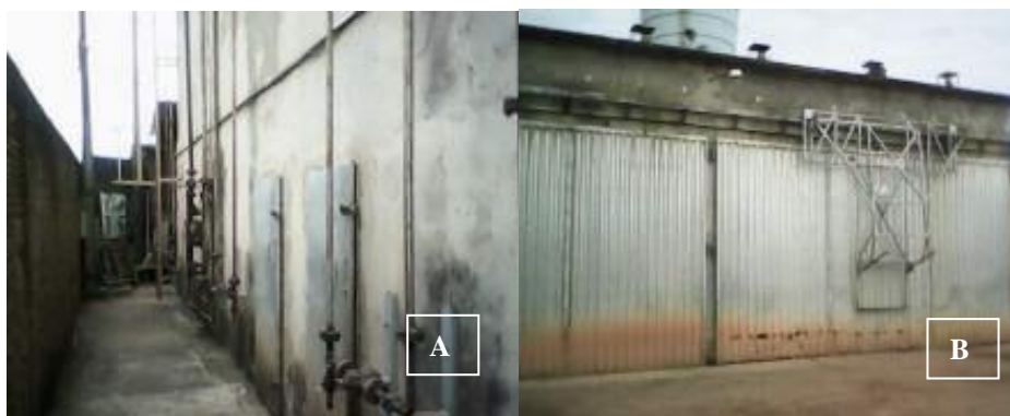
Figura 1-A: Vista posterior da estufa com porta de entrada para trabalhadores. 1-B: Vista frontal da estufa com portões de entrada para madeiras.
