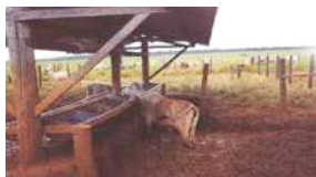
Fig.1: Cocho em condições precárias de utilização – Fonte: Power Point de aula do Professor Paulo Roberto Leme – Faculdade de Zootecnia e Engenharia de Alimentos – USP Pirassununga.
