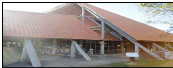
Fig. 1: Vista Lateral - Casarão. (Fonte: Emanuella, 2013).
