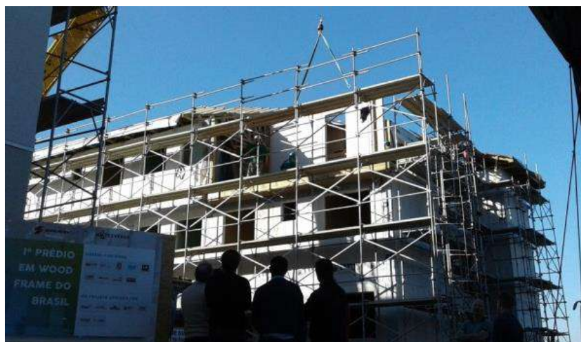
Figura 4. Montagem do primeiro edifício habitacional wood frame do Brasil Fonte: Arquivo Pessoal (2016)
