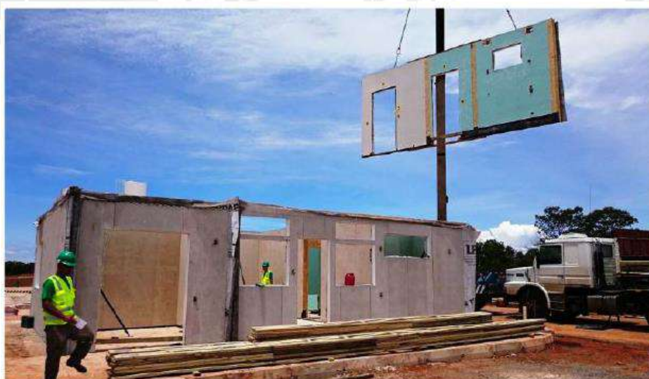
Figura 6. Exemplo de painel fechado sendo montado em obra Fonte: Tecverde Engenharia S/A (2016).
