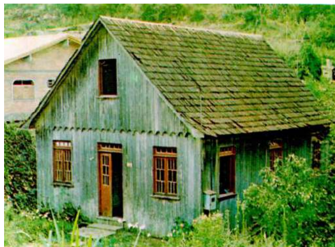
Figura 4. Casa em madeira com cobertura de duas água em madeira. Fonte: POSENATO, 1983.
