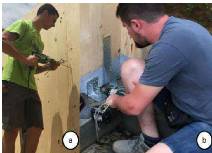
Figura 2. Fixação entre placas (a) e fixação dos painéis nas vigas baldrame (b).
