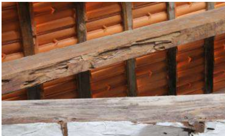
Figura 2. Ataque por agente xilófago (cupins). Fonte: BOURSCHEID, 2015 (arquivo pessoal).
