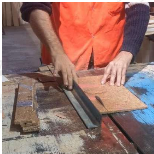
Figura 4. Painéis sendo serrados nas medidas exigidas por norma
