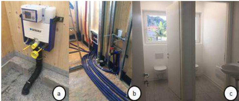
Figura 6. Caixa acoplada de descarga (a), Instalação dos canos (b), Lavabo concluído (c).
