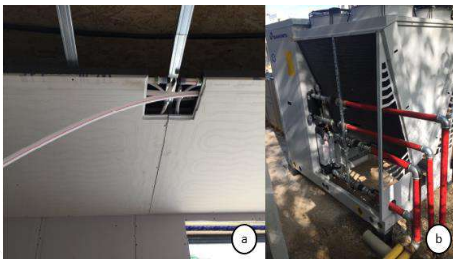
Figura 11. Colocação das placas com serpentinas embutidas (a), Sistema Chiller (b).
