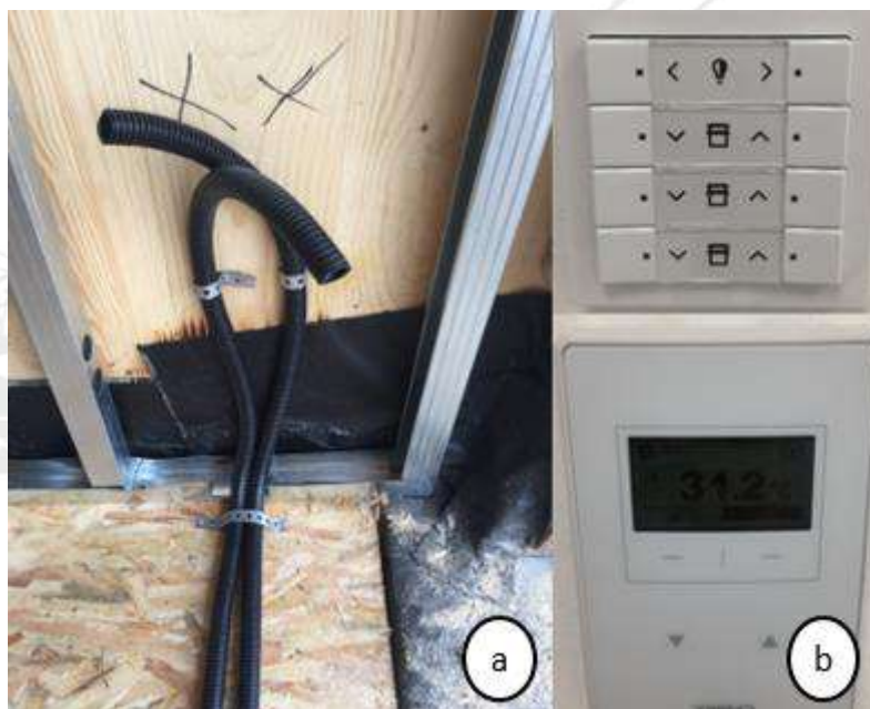
Figura 7. Instalação dos dutos elétricos (a), Controles da edificação (b).
