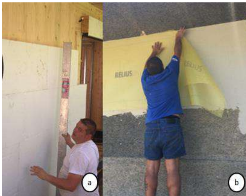
Figura 8. Colocação das placas de poliestireno expandido (a), Colocação de tela estrutural
